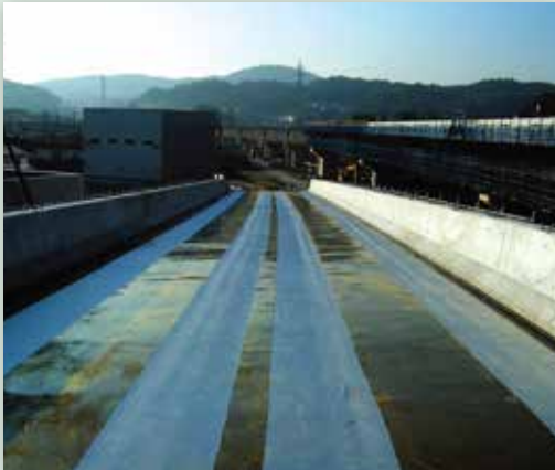
舗装時の工事用車両走行ラインへ 特殊クロスを敷設
