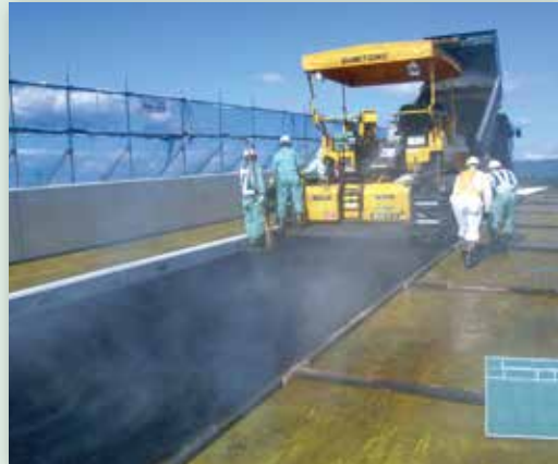
アスファルト舗装
